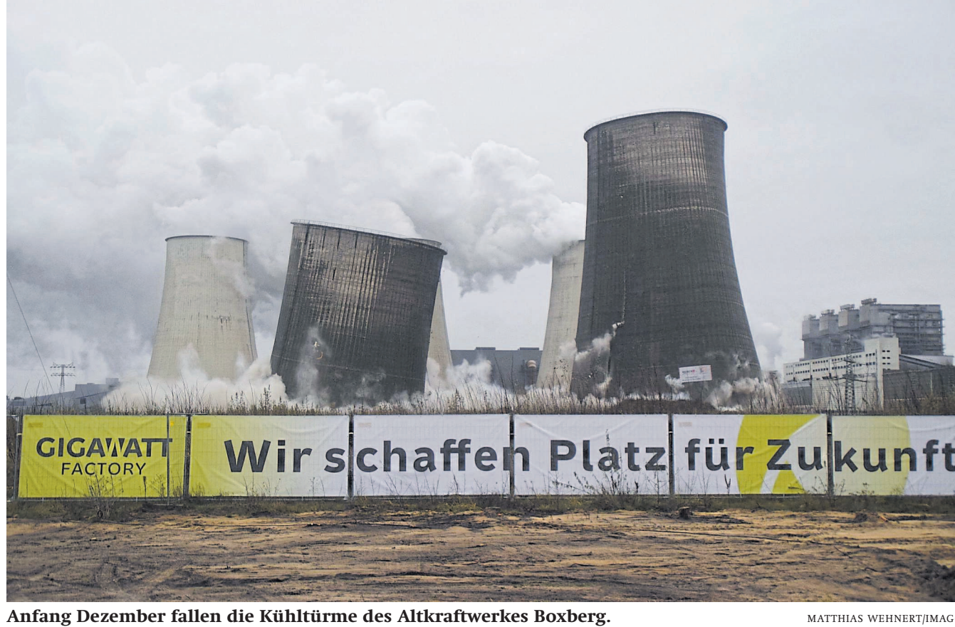
Anfang Dezember fallen die Kühltürme des Altkraftwerkes Boxberg.
